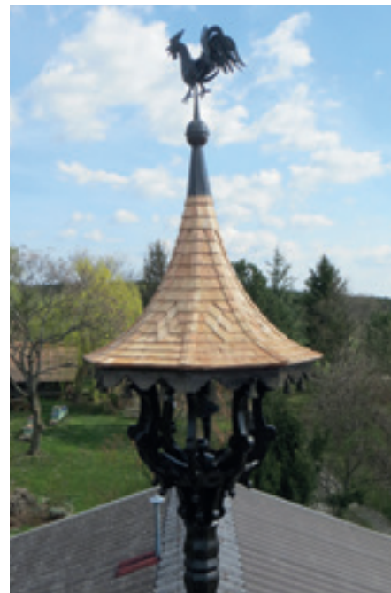
Wetterbahn am Schindelkegeldach. Foto: z. V. g.
